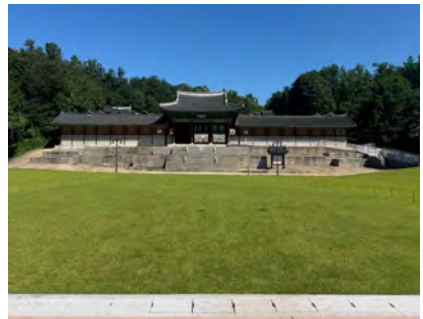
궁궐 전면부 바닥정비 및 잔디포장 (공사후)
