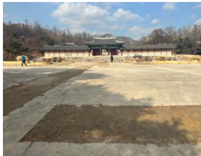
궁궐 전면부 노후 바닥 포장 (공사전)
