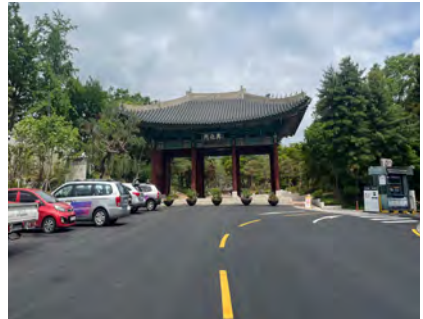
경희궁 진입부 바닥 정비 (공사후)
